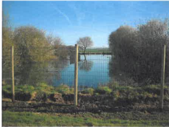
Réserve à incendie de 4 700 m 3
